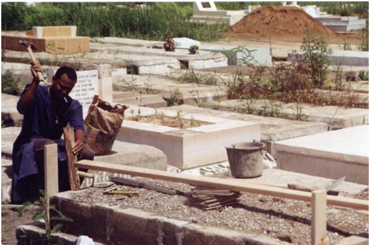
Afbeelding 12: Metselen van een 'kelder', rk-begraafplaats (Louis Noorlander)
